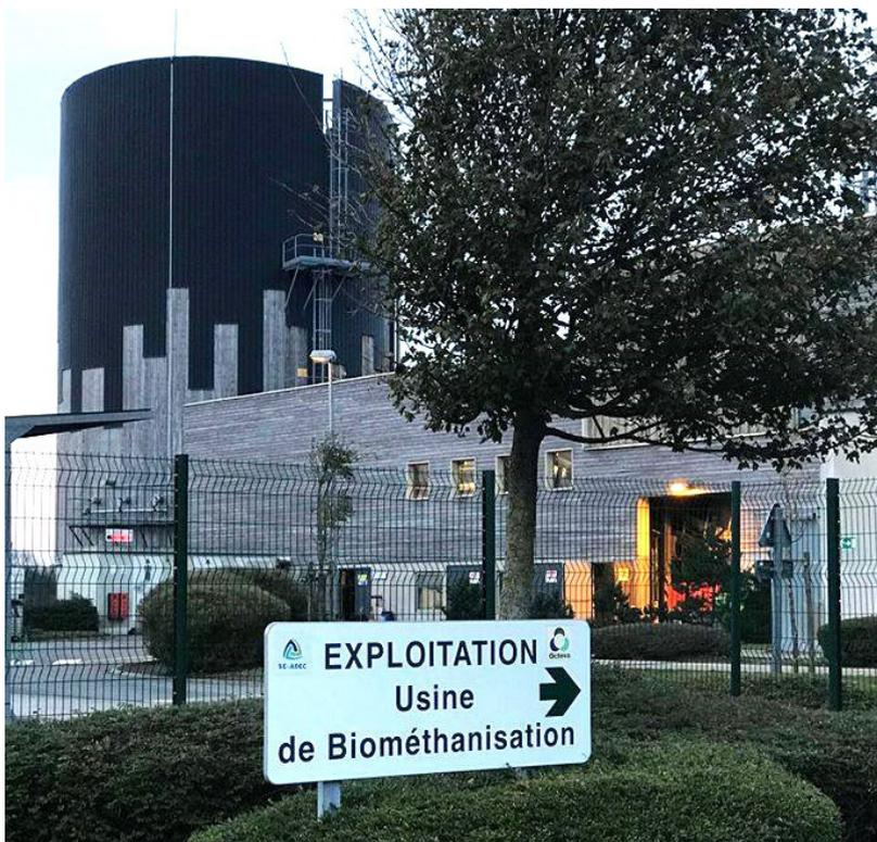
La biométhanisation a pour effet de réduire considérablement la charge organique. Le compost produit est ensuite valorisé en milieu agricole et au niveau des particuliers. Le biogaz est, quant à lui, envoyé prioritairement vers les groupes électrogènes et la chaudière de cogénération afin de produire de l'électricité verte et de la chaleur grâce à cette dernière.
