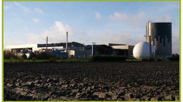
La biométhanisation a pour effet de réduire considérablement la charge organique. Le compost produit est ensuite valorisé en milieu agricole et au niveau des particuliers. Le biogaz est, quant à lui, envoyé prioritairement vers les groupes électrogènes et la chaudière de cogénération afin de produire de l'électricité verte et de la chaleur grâce à cette dernière.
