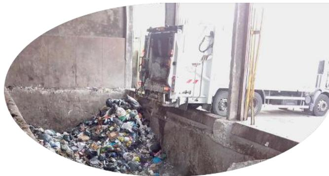
Le **centre de transfert** est une installation intermédiaire entre la collecte et le traitement des déchets. Il permet de créer une rupture de charge afin de regrouper les déchets dans des moyens de transports plus grands, tels que des semi-remorques.
