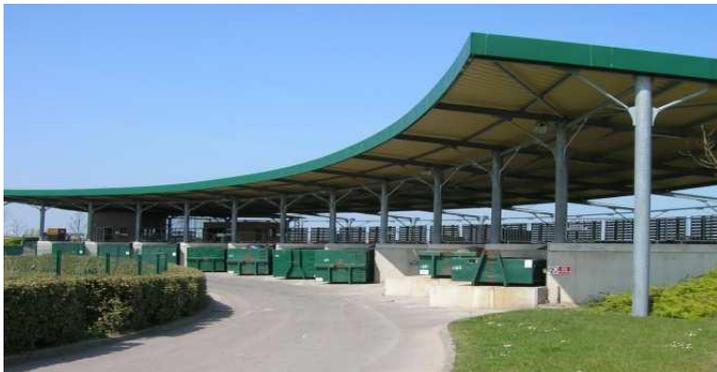
*Un centre de transfert* des ordures ménagères est une installation intermédiaire entre la collecte et le traitement des déchets. Il permet de créer une rupture de charge afin de regrouper des déchets dans de plus grand moyen de transport. Ils sont stockés dans une fosse par type de déchets (ordures ménagères brutes et déchets verts) puis sont chargés dans des semi-remorques pour être envoyés vers leurs lieux de traitement respectifs. (Capacité: 86 000 tonnes/ an)
