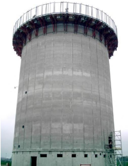
*La coulée du béton en continu a duré 5 jours et 24h/24 grâce à un système de coffrage coulissant. C'est un cylindre en béton de 21,20 mètres de hauteur qui a ainsi vu le jour, une véritable performance technique qui a nécessité 400 m<sup>3</sup> de béton, 15 tonnes d'acier, la présence de 45 personnes pendant une semaine et qui nécessitera 3 millions de litres d'eau pour faire les essais de fonctionnement.*
